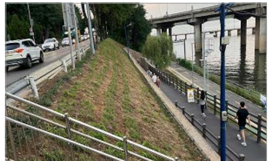
안양천 제방 녹화사업지 공사 후
